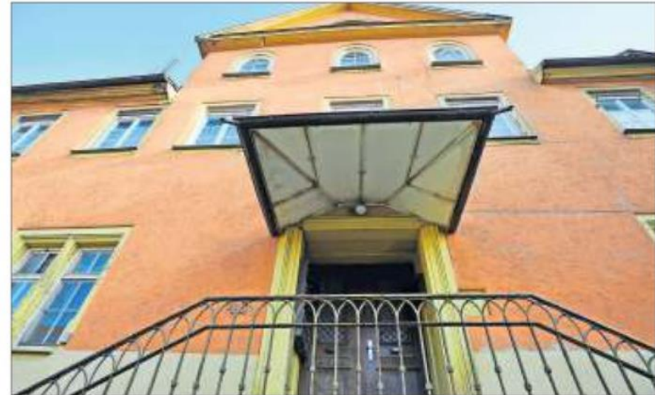
Im Dachgeschoss des Schloßles entsteht Wohnraum für vier Flüchtlinge. Foto: Werner Kuhnle
